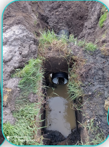
Rue des Aubépines : busage de 54 mètres de fossé et mise en place d'un regard
