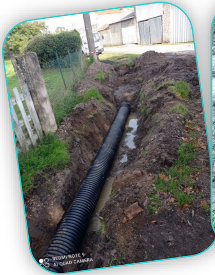
Rue des Aubépines : busage de 54 mètres de fossé et mise en place d'un regard
