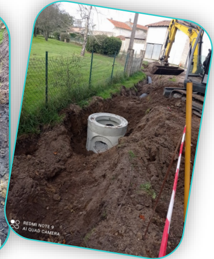
Rue des Aubépines : busage de 54 mètres de fossé et mise en place d'un regard
