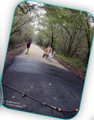
Rue des Aubépines : busage de 54 mètres de fossé et mise en place d'un regard
