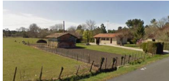
Constructions diffuses au niveau de Peyblanc
