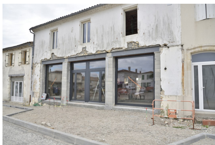
Commerces Pose des menuiseries terminée Électricité en cours
