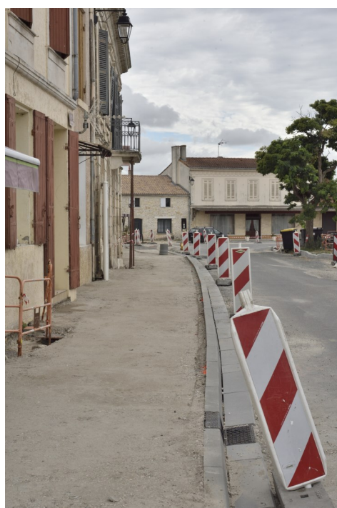
Élargissement des trottoirs Place du XI Novembre 1918
