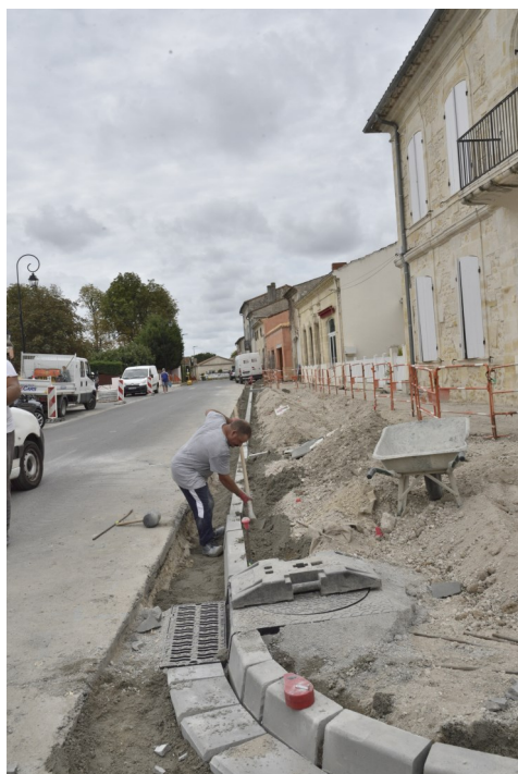
Mise en place des bordures Rue du 8 Mai 1945
